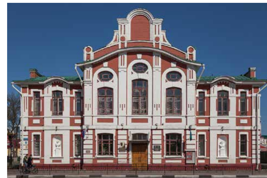
Здание Тамбовского музыкально-педагогического института после реставрации
