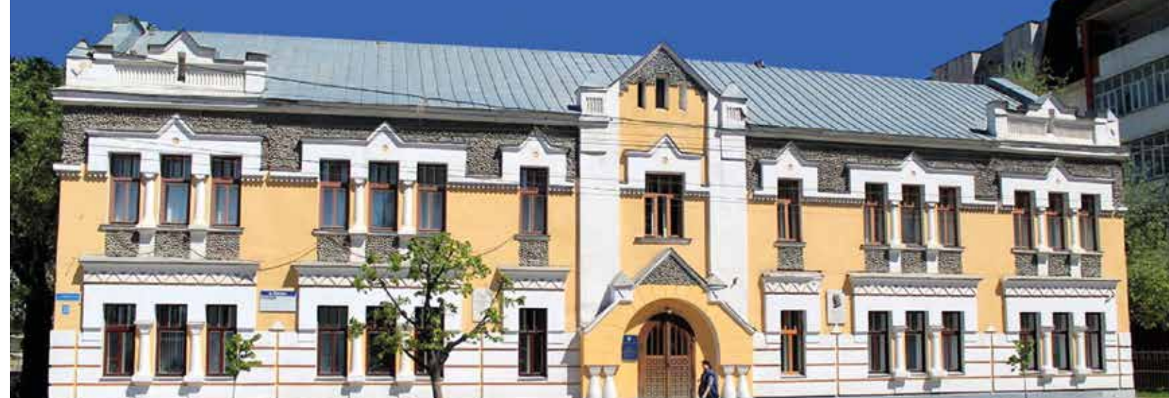
Здание художественной школы № 1 г. Тамбова в стиле модерн. Многие выпускники школы стали студентами, архитекторами
