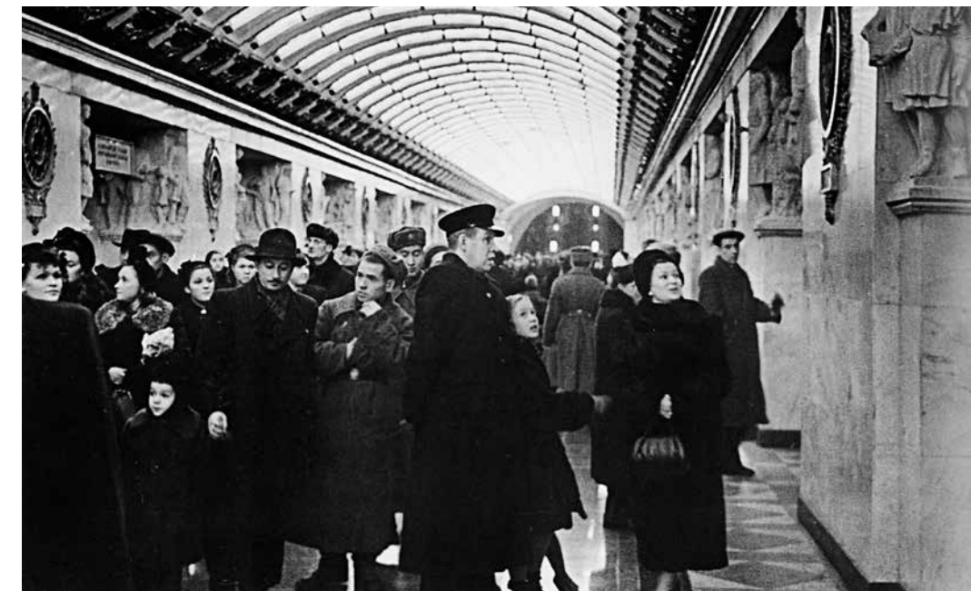
Станция метро «Нарвская». 1955 г.
